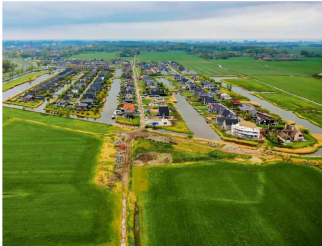
Blitsaerd-West (het bebouwde deel van de wijk) is bijna gereed. Hier pal naast (de weilanden op de voorgrond) komt De Finish. Dit wordt het meest intensief bebouwde deel van Blitsaerd-Oost. De Bonke en de Groningerstraatweg zijn links op de foto te zien. FOTO LC/ARODI BUITENWERF
