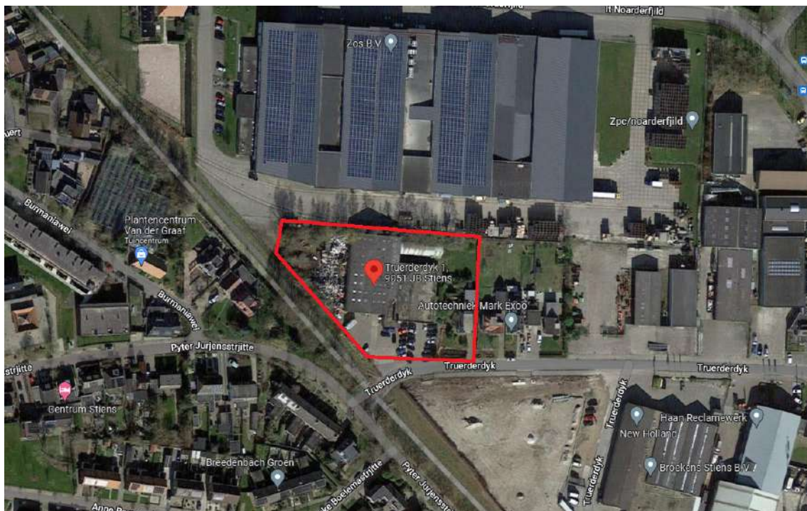
Figuur 1.2 Luchtfoto plangebied (bron: Google maps)
