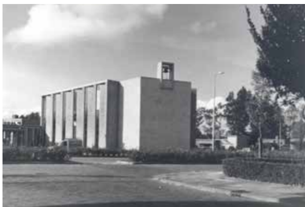
Figuur 8. De voormalige Fenixkerk, Beeldbank HCL, foto graaf H.J. Zijlstra
