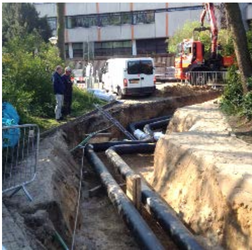
Impressie/ impact en herstel sleuf warmtenet
