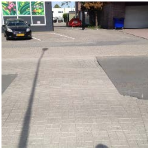
Impressie/ impact en herstel sleuf warmtenet
